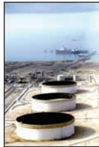
Riba un foto di archivo, por mira un tanker carga di petrolio na haf di e refinaria na Lavan.
